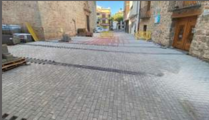
Junio 2022 Finalización de obras de repavimentación en la plaza
